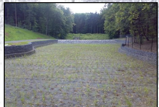
Bodenfilter nach Bepflanzung
