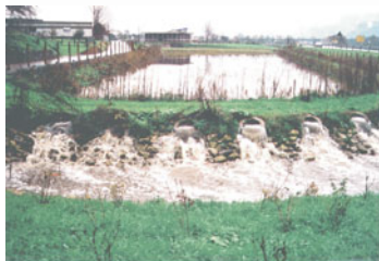
▲ Bodenfilterüberlauf
