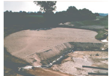
► Baustelle Retentions-Bodenfilter
