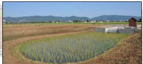
Ansicht Bodenfilter von Westen
