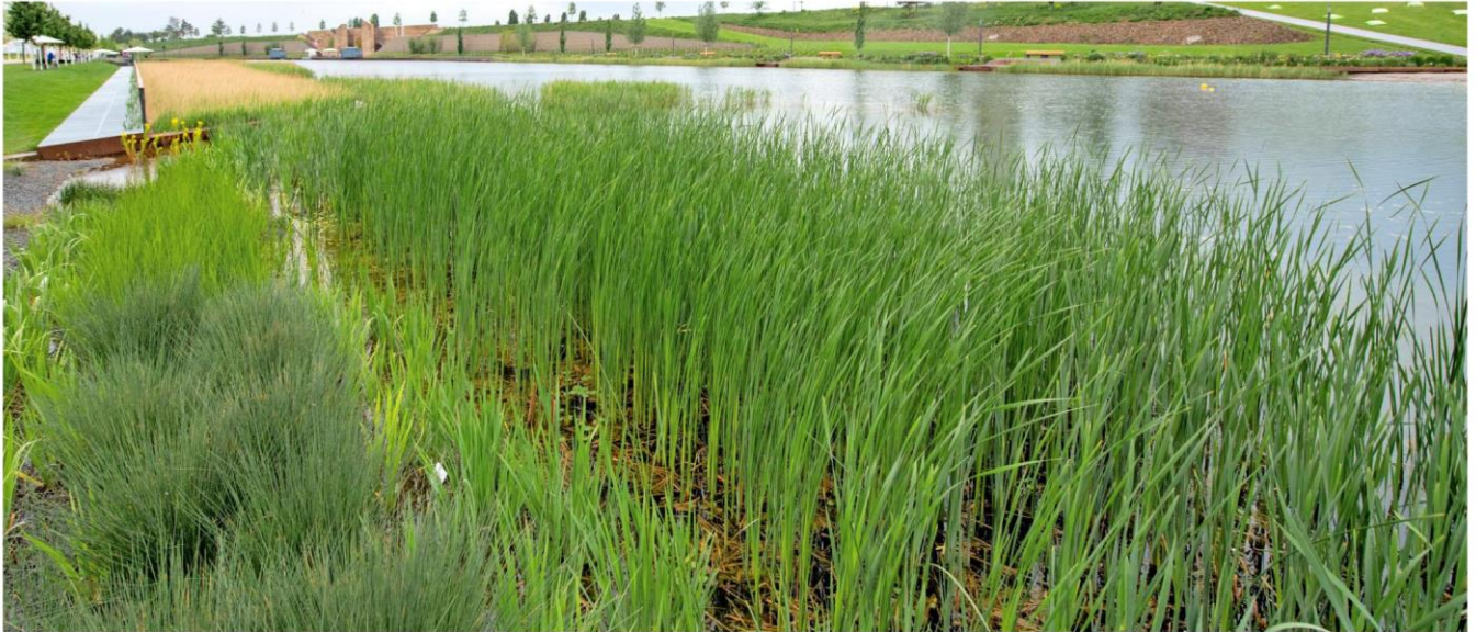
Über die schilfbewachsene Retentionsbodenfilteranlage fließt sauberes und nährstoffarmes Regenwasser in den Floßhafen und den Karlssee. Die Seen haben eine Fläche von 34 000 Quadratmetern. Fotos: Mario Berger
