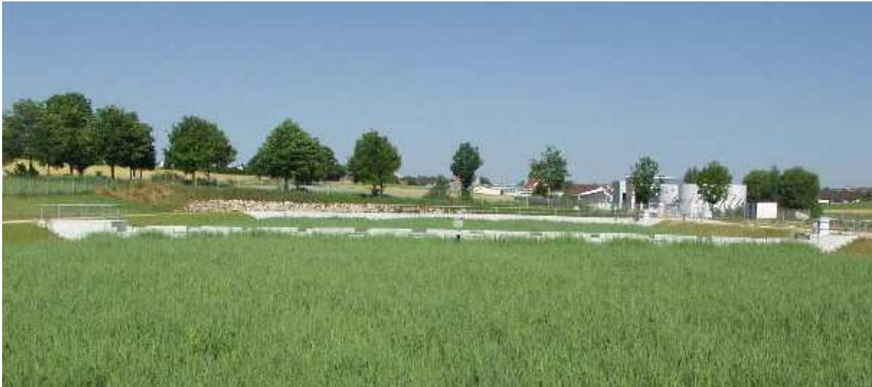
Abbildung 2: Retentionsbodenfilter Monheim mit 2 Beeten (im Vordergrund Beet 2, im Hintergrund Beet 1)
