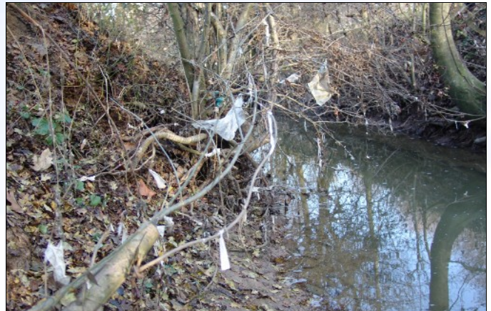
Mühlbachbelastungen aus der Mischwasserkanalisation vor dem Umbau der RÜB's
